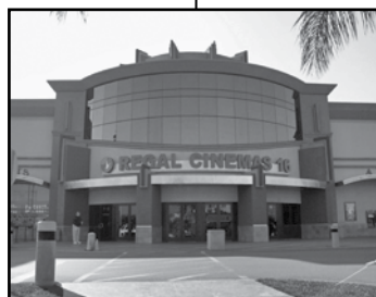
Regal Cinemas, Escondido
